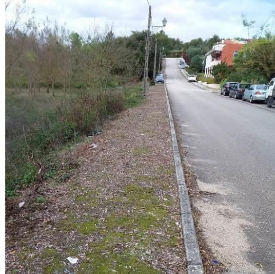
Propõe-se a requalificação do arruamento de forma a adequar o perfil atual e a zona de circulação automóvel, em toda a extensão, à inclusão de áreas de circulação pedonal e zonas de marcação de estacionamento. Propõe-se ainda a reestruturação das redes de infraestruturas em subsolo, e da rede de iluminação pública, bem como a atualização dos elementos de sinalização vertical e de sinalização horizontal, e a plantação de espécies verdes (árvores ou outras).
