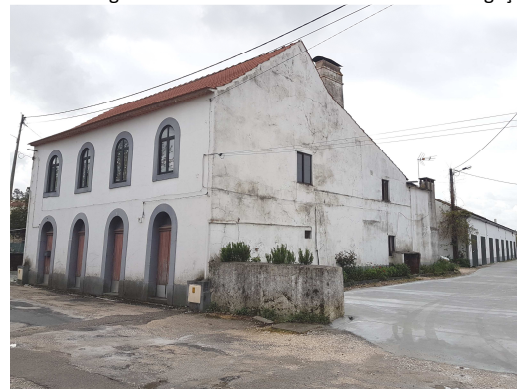
Figura 11: Imóvel a reabilitar na rua Maria Fogaça
