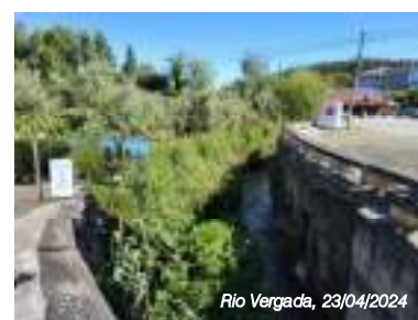
Impermeabilização das margens e estruturas com fracas condições estruturais
