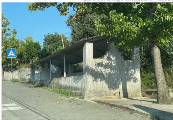
Figura 10: antigo Lavadouro Público
