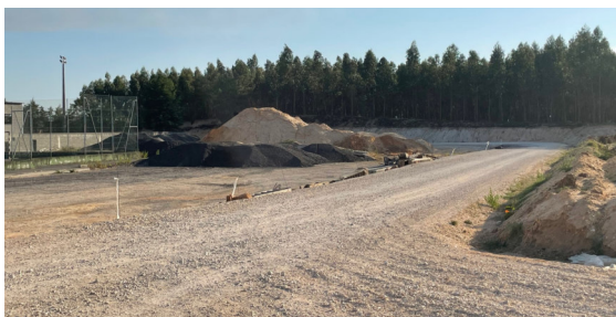
Figura 30: Obras de urbanização da Zona Desportiva e Escolar
