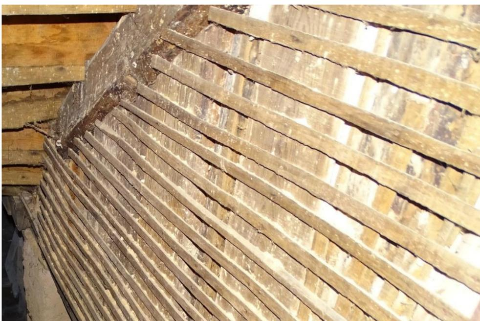
Figura 12: Paredes divisórias em tabique
