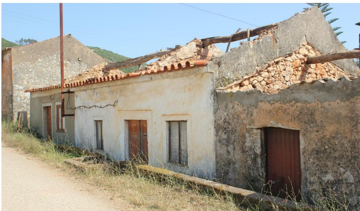
Figura 7: Construções em alvenaria de calcário na Rua Nossa Senhora da Estrela
