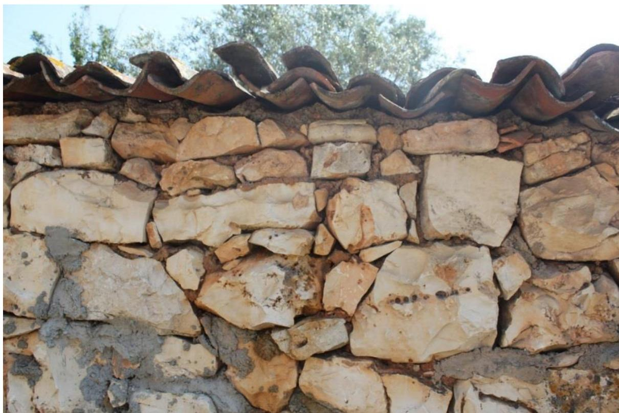
Figura 9: Utilização da argila como argamassa no assentamento de alvenaria de pedra
