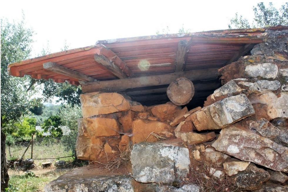
Figura 11: Cobertura com estrutura de madeira na ARU de Poios
