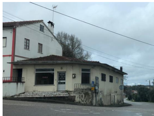
Figura 25: Edifício na rua João de Barros
