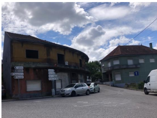
Figura 24: Edifícios na rua João de Barros
