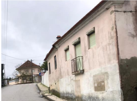
Figura 22: Edifício na rua dos Combatentes
