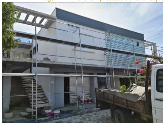
Imagem 22: Imóvel em processo de reabilitação
