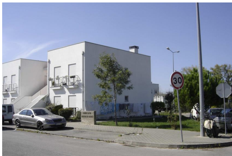
Figura 6. Bairro Social Margens do Arunca
