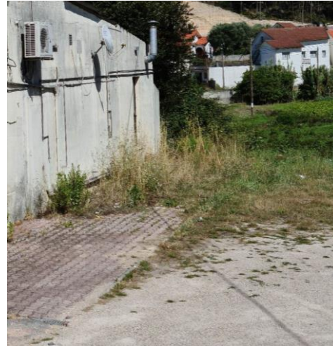
Imagem 26: Terreno proposto para a execução do percurso
