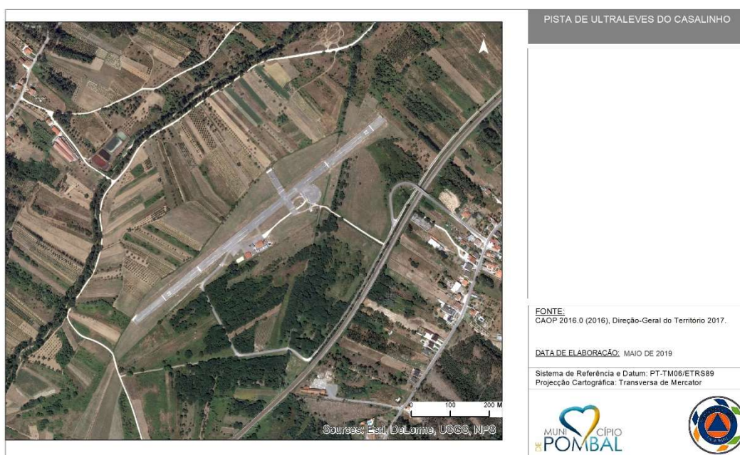
Figura 15: Pormenor da Pista de Ultraleves do Casalinho.
