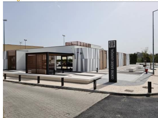
Imagem 17: rua da Cerca e rua fronteira ao Centro de Saúde
