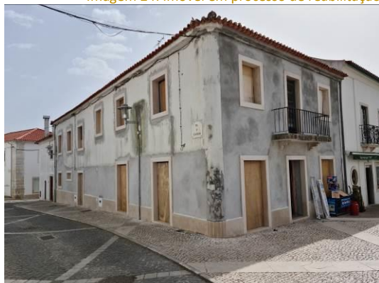
Imagem 24: Imóvel em processo de reabilitação
