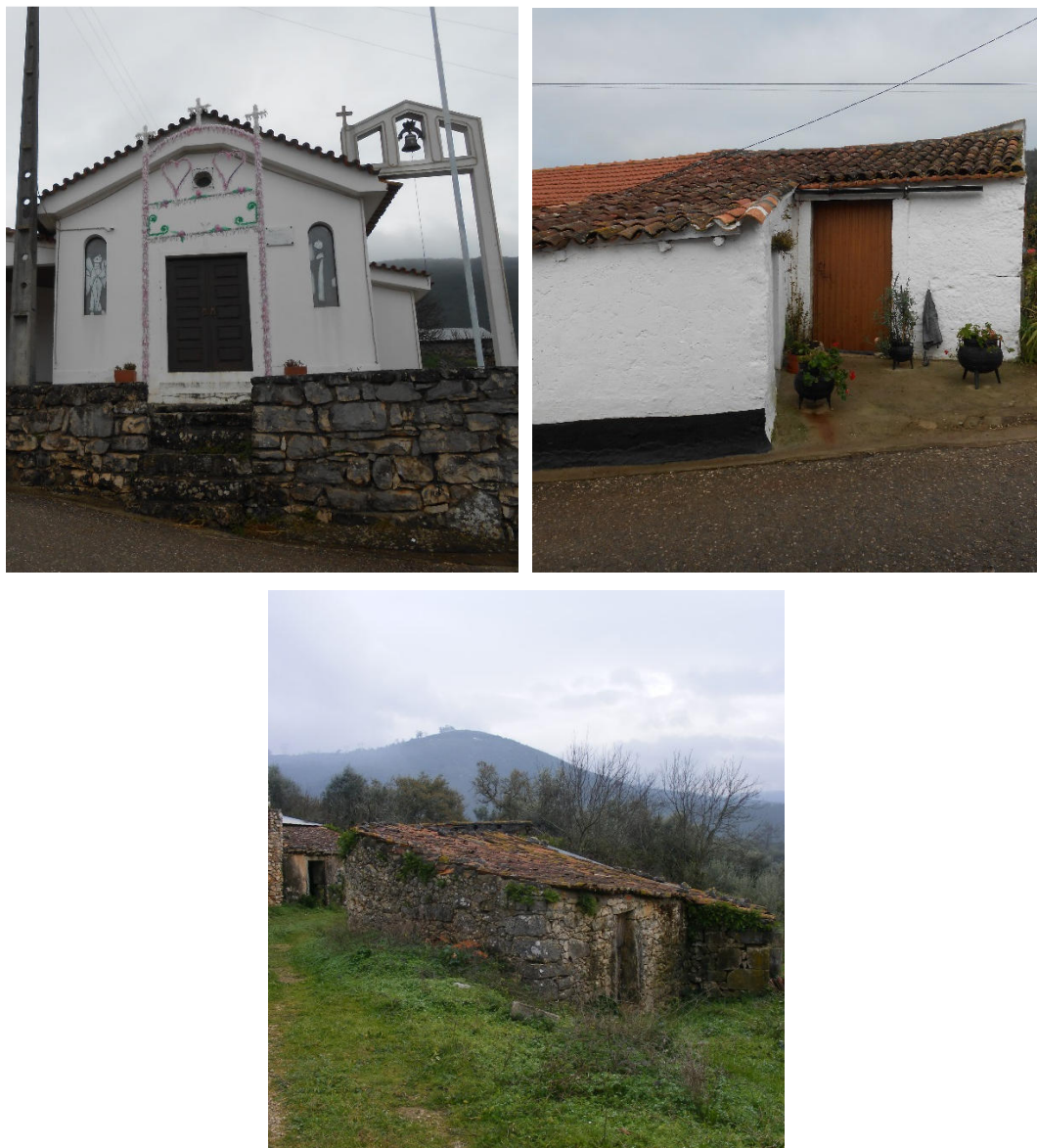
Figura 10: Exemplos de património arquitetónico existente na ARU
