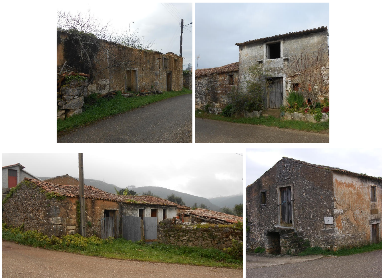
Figura 8: Edifício em ruína ou em mau estado de conservação na ARU
