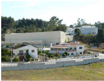
Figura 17: Vista sobre o pavilhão gimnodesportivo
