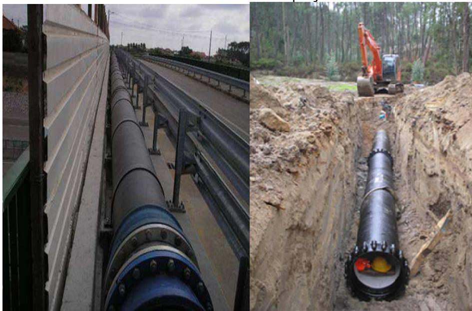
*Foto n.º I- Obras de execução da conduta adutora em ferro fundido dúctil DN 600mm*
