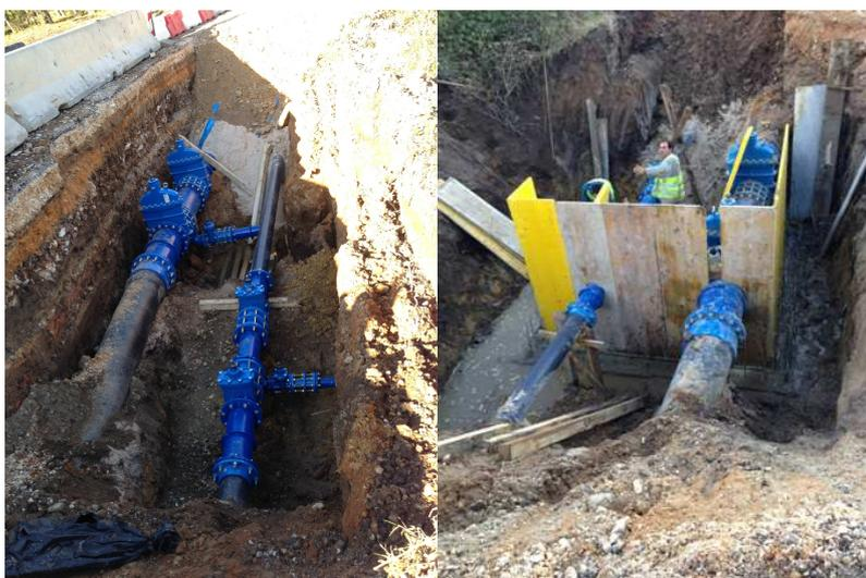
Foto n.º II- Obras de execução das condutas que permitem a ligação das novas infra-estruras às já existentes
