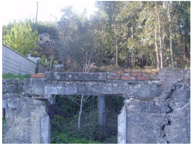
Deslizamento na Murzeira data- 27/01/2012
