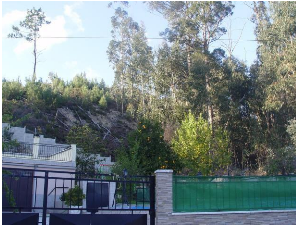
Deslizamento na Murzeira data- 27/01/2012
