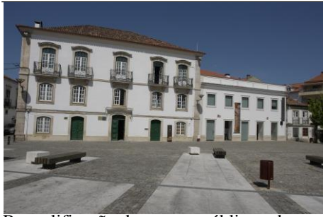
Requalificação do espaço público urbano na cidade de Pombal (2010)
