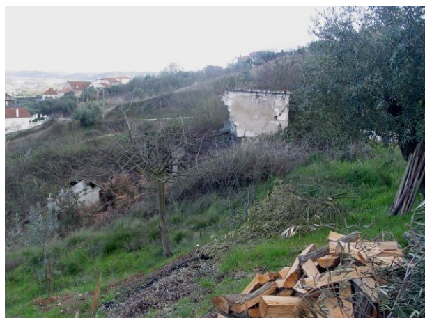
Deslizamento do Sourão data– 15/03/2011 e 27/01/2012
