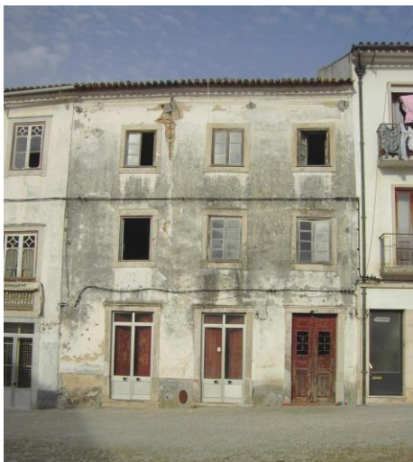
Degradação física do edificado no centro histórico da cidade de Pombal ( 2007)
