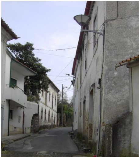
Degradação de eixos viários de acesso e ruas estreitas ao centro histórico da cidade de Pombal ( 2007)
