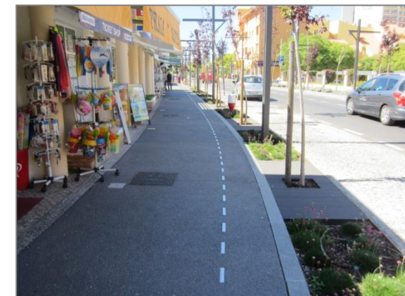
Percurso acessível com corredor pedonal livre
