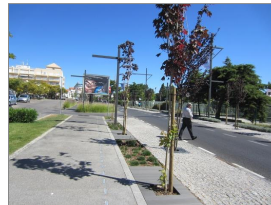
Percurso acessível com corredor pedonal livre
