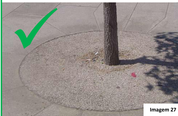
Resina compactada devidamente colocada
