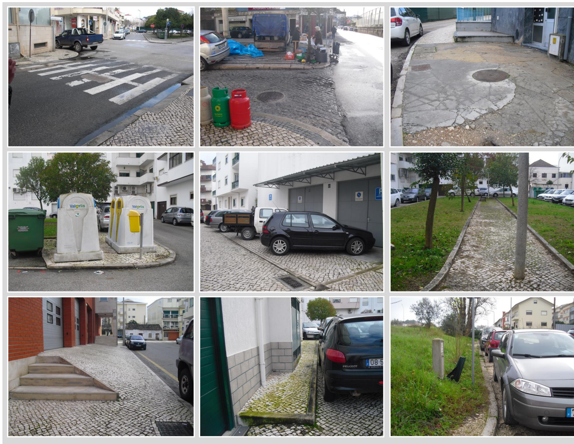
Figura 2.1. Barreiras presentes no espaço público da cidade de Pombal
