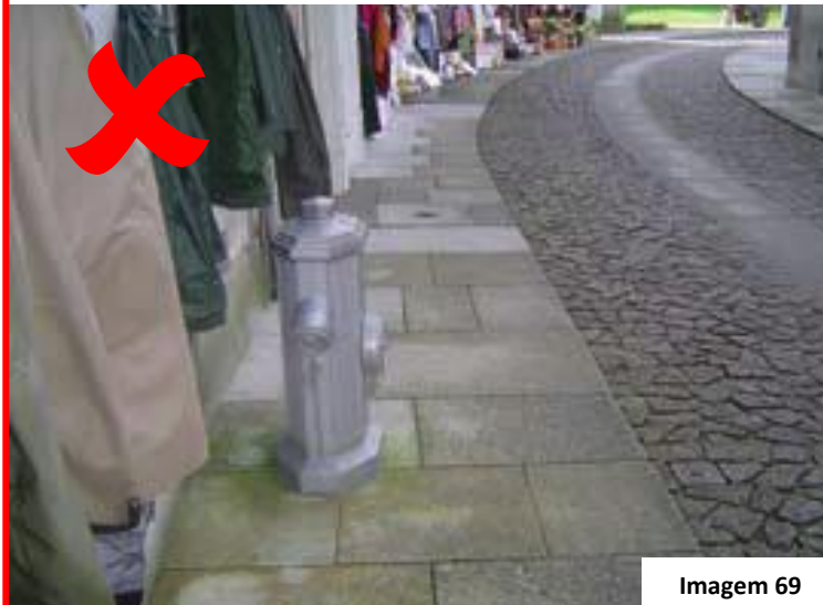
Boca-de-incêndio no meio do passeio
