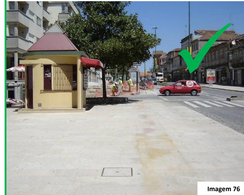
Quiosque fora do canal acessível
