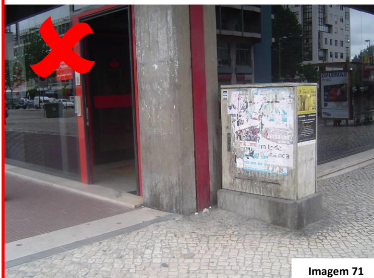
Armário localizado no passeio de forma incorreta
