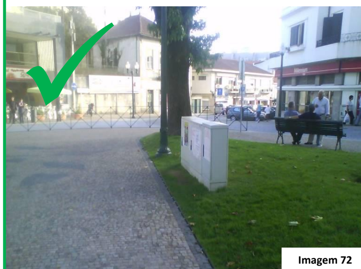
Armário corretamente localizado
