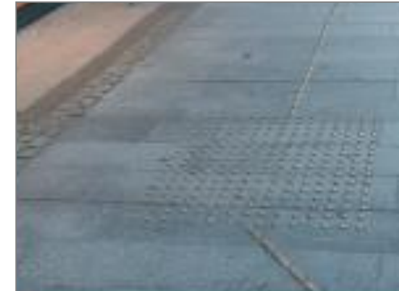
Pavimento com orientação para cegos
