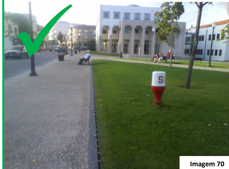
Boca-de-incêndio com design e localização corretos
