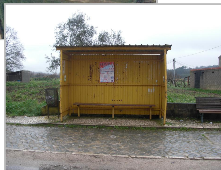
Figura 6.15. Exemplos das infraestruturas de apoio ao transporte coletivo rodoviário identificadas na freguesia de Redinha, município de Pombal
