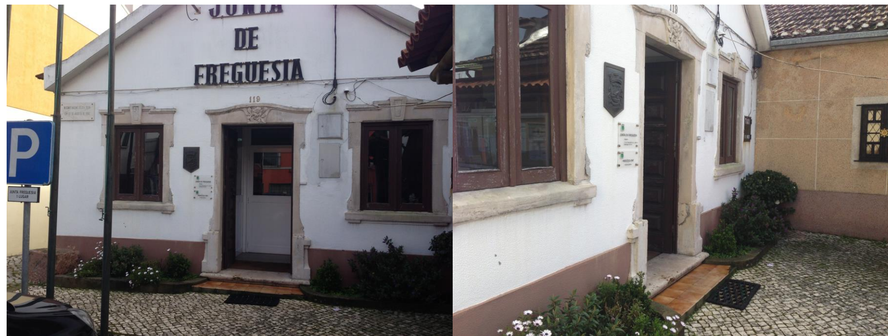
ESPAÇO EXTERIOR E PORTA DE ACESSO À JUNTA DE FREGUESIA DE GUIA
