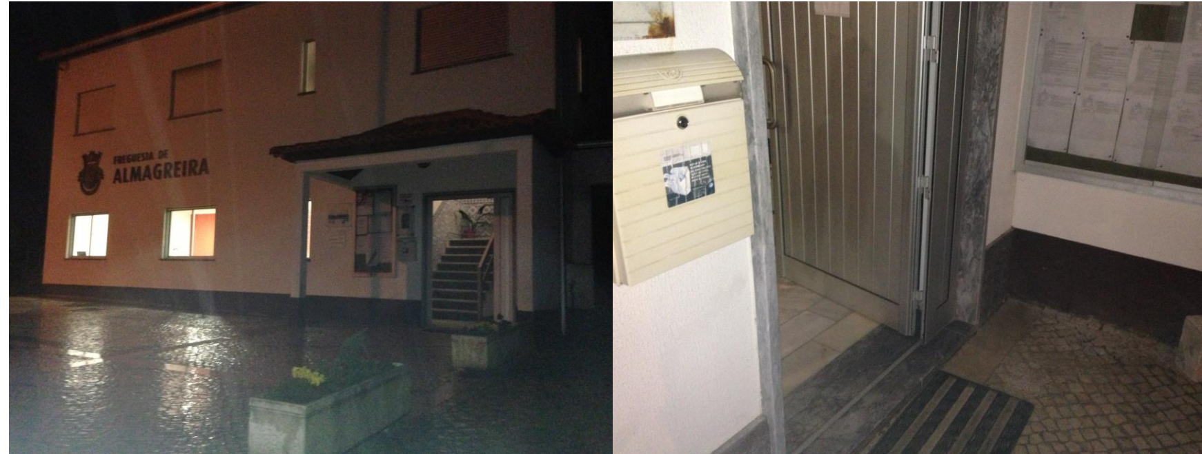
EXTERIOR E PORTA DE ACESSO À JUNTA DE FREGUESIA DE ALMAGREIRA
