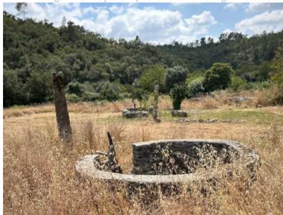
Imagem 79: Poços em pedra calcária de argamassa seca
