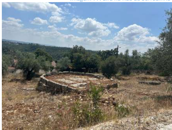
Imagem 79: Poços em pedra calcária de argamassa seca
