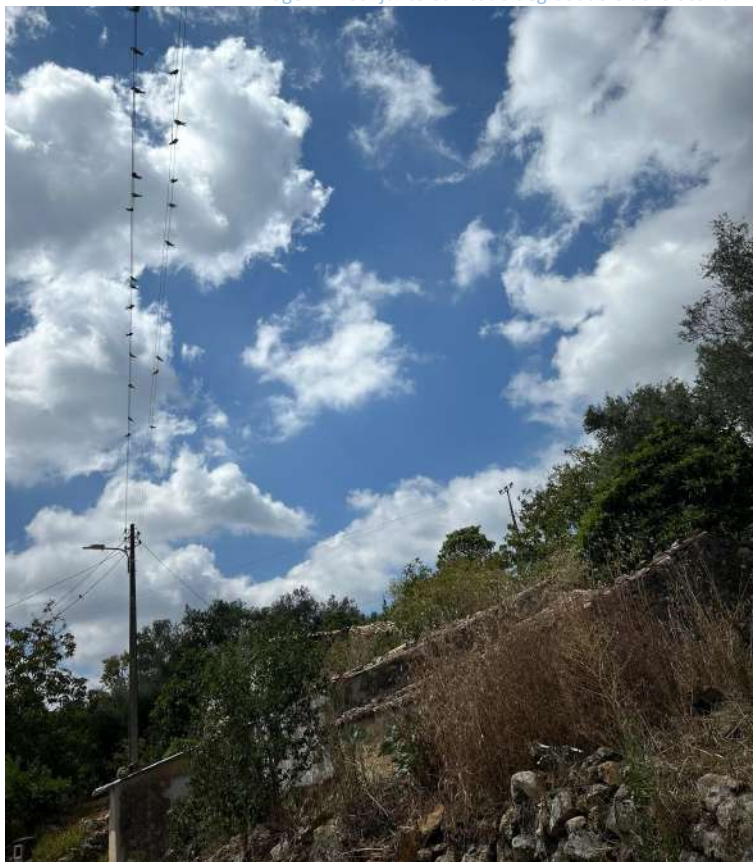
Imagem 2: Conjunto edificado degradado e devoluto na Travessa das Pregueiras
