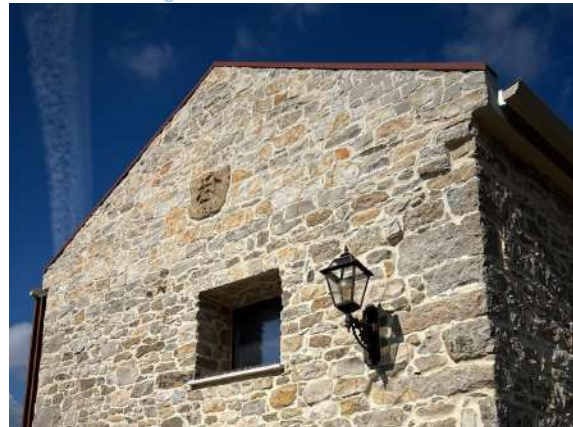
Imagem 25: Imóvel reabilitado na Rua dos Abreus
