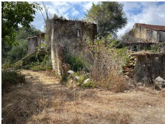
Imagem 40: Rua das Lajes
