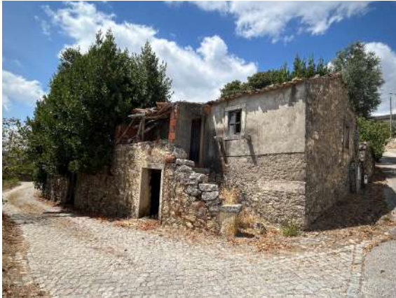
Imagem 42: Imóvel degradado e devoluto na Trav. da Tapada
