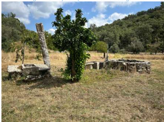
Imagem 78: Poço em pedra calcária de argamassa seca
