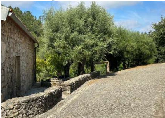
Imagem 46: Imóvel reabilitado na Rua do Canto
