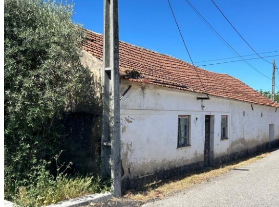
Imagem 44: Imóvel degradado e devoluto na Rua Sto António
