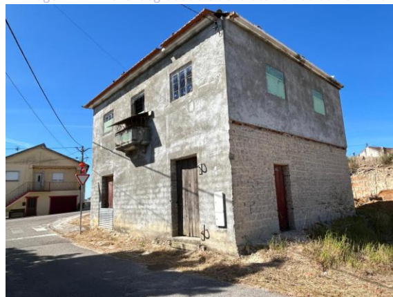
Imagem 42: Imóvel degradado e devoluto na Rua da Relvinha
