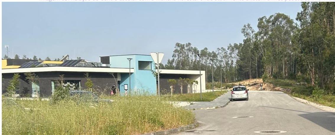
Imagem 63: Relação do Centro Escolar com a mancha florestal onde atualmente existem trilhos pedestres informais
