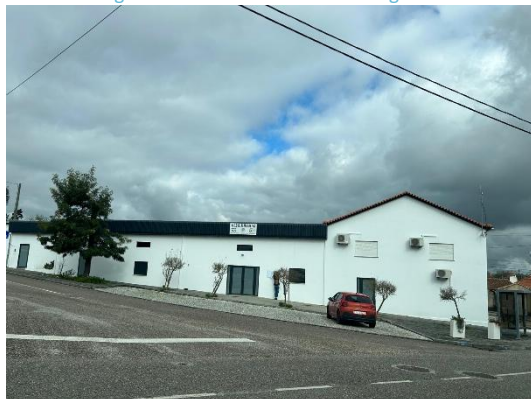
Imagem 23: Edifício da Junta de Freguesia e ACDRA
