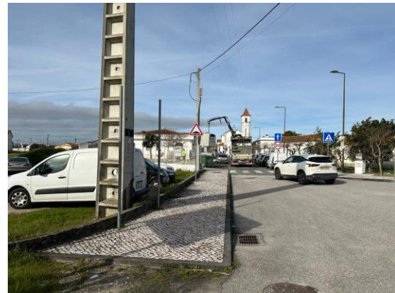
Figura 31: Ligação da Avenida da Igreja com a EN 109
