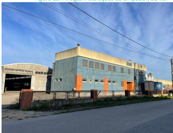
Figura 15: Antigas instalações da Empobor/Borvul
