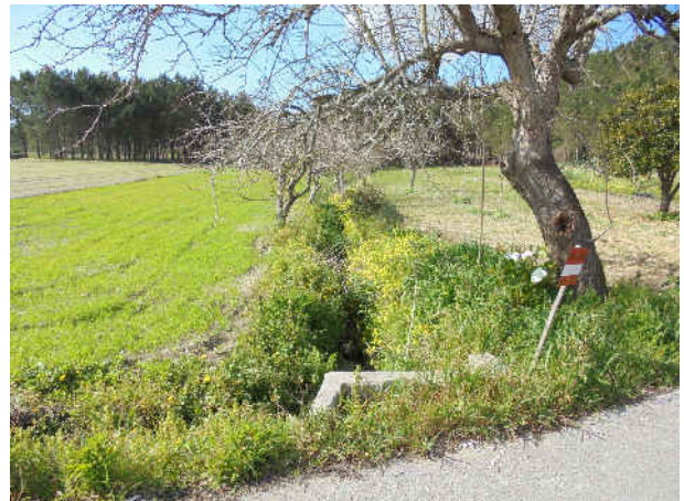
Linha de água perpendicular à rua que interliga a Rua do Barreiro com a Rua da Fonte do Rei (lado Oeste) (Fotografia de 10/03/2016)
