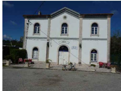
Figura 23: Edifício Concessionário ao Bar Santa Apolónia - Fotografia de 11 de abril de 2016
