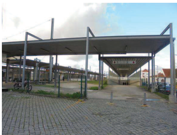
Figura 18: Acesso pedonal inferior de passagem sob a Linha do Norte
