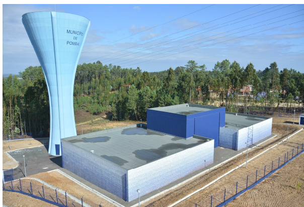
Foto n.º II - Reservatório do Parque Industrial de Pombal
