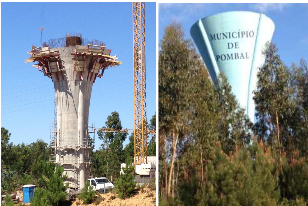
Foto n.º IV- Reservatório em fase de construção no PIP e já concluído no Outeiro da Ranha
