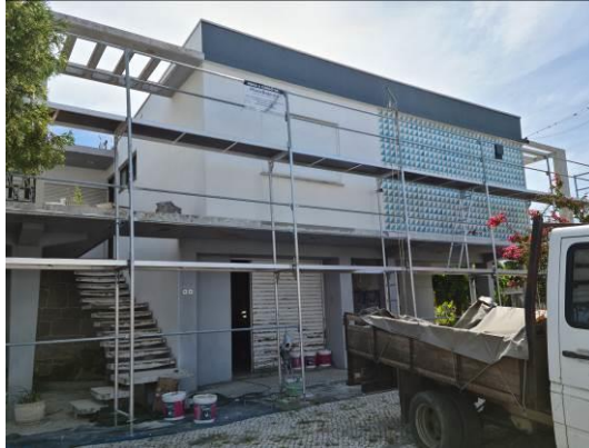
Imagem 22: Imóvel em processo de reabilitação
