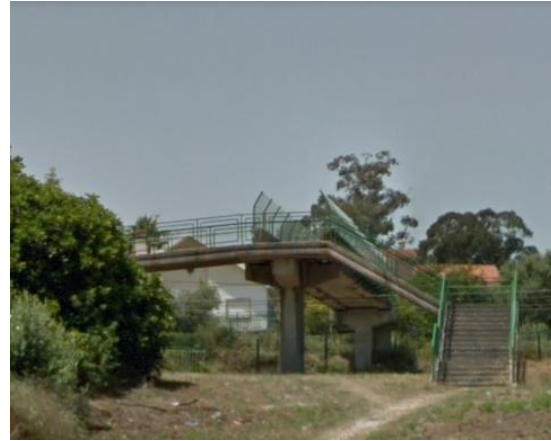
Imagem 30: Passagem Superior sobre a Linha do Norte
