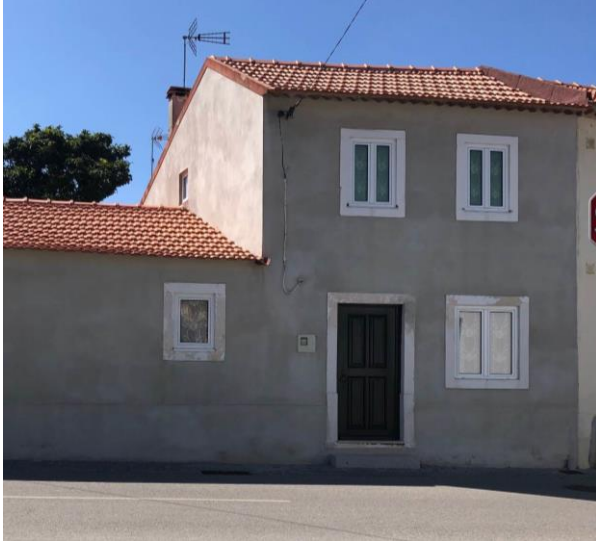
Imagem 17: Imóvel em processo de reabilitação
