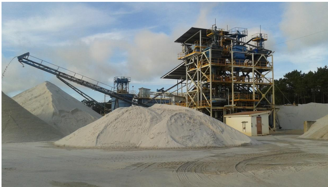
Fotografia 2 – Vista da instalação de processamento de areias.
