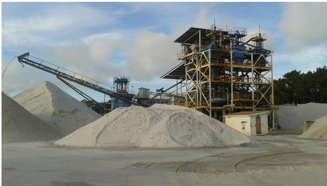
Fotografia 2 – Vista da instalação de processamento de areias.
