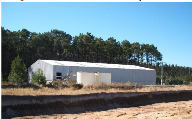
Fotografias 3 e 4 – Vistas da instalação de caulinos.
