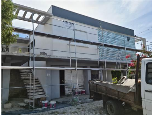
Imagem 22: Imóvel em processo de reabilitação
