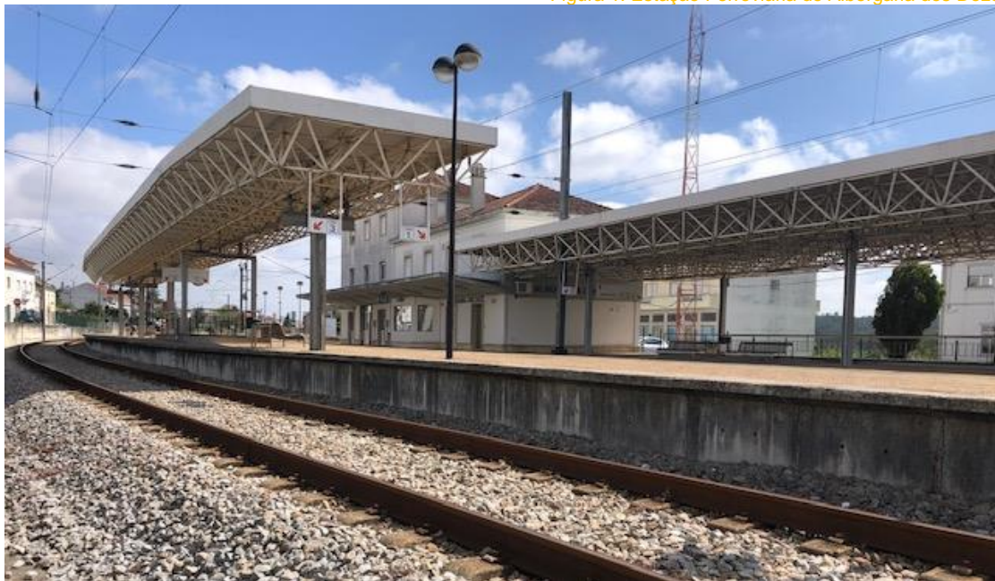
Figura 1: Estação Ferroviária de Albergaria dos Doze
