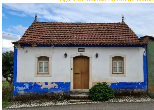
Figura 16: edifício na rua do Outeiro
