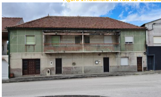
Figura 17: edifício na rua do Castelo
