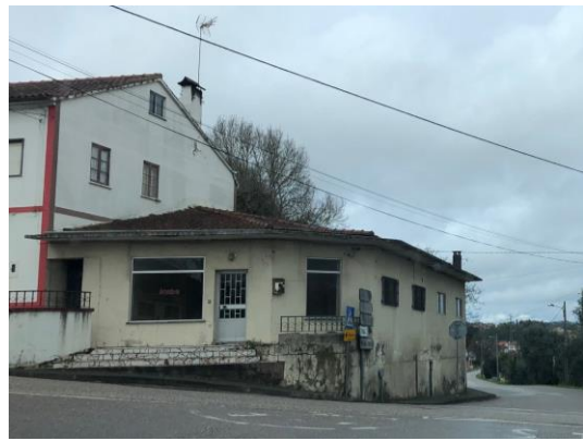
Figura 25: Edifício na rua João de Barros
