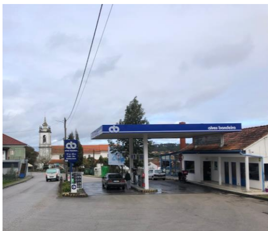
Figura 16: Posto de combustível
