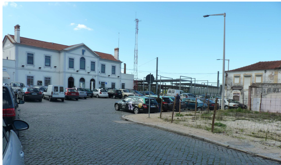
Figura 22 – Rua Alexandre Herculano e Largo Salgueiro Maia
