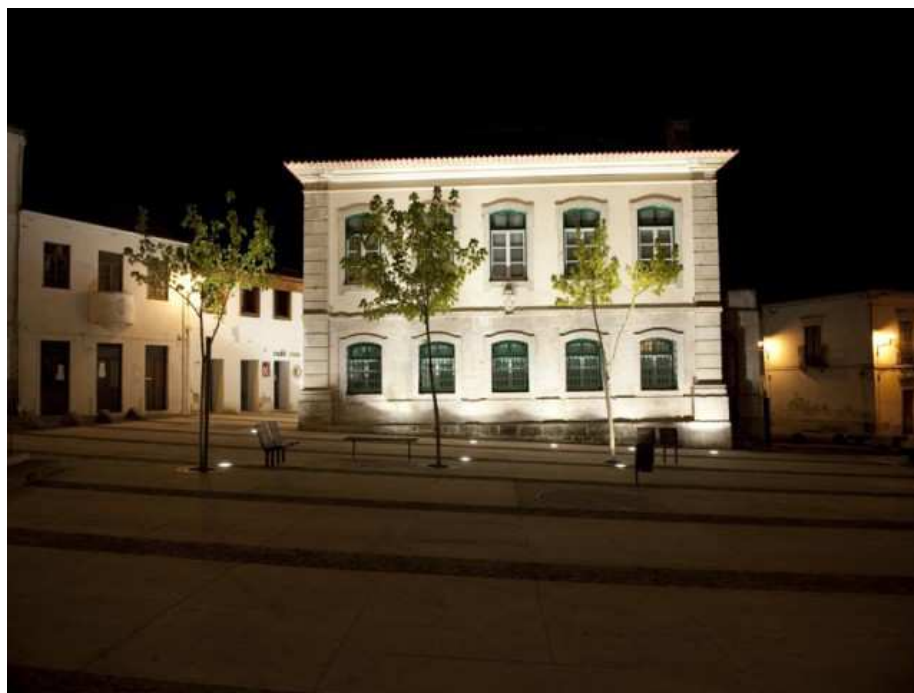
Figura 28 – Requalificação da praça velha no centro histórico
