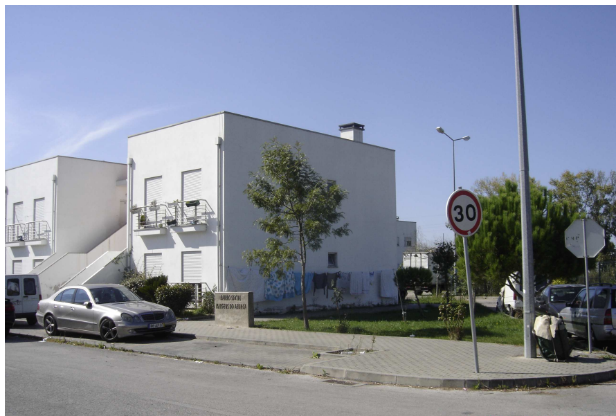
Figura 55 – Bairro social Margens do Arunca
