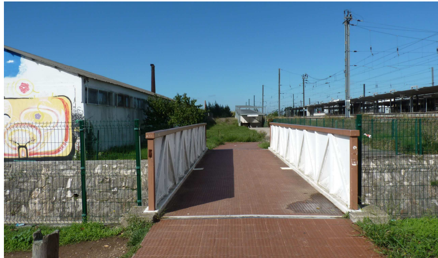
Figura 21 – Acesso a passagem pedonal inferior à linha de caminhos de ferro
