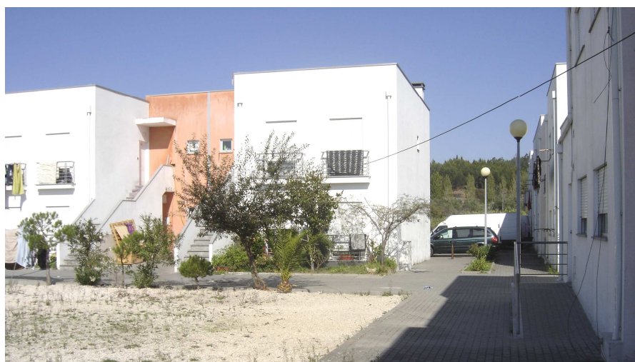
Figura 60 – Fachadas posteriores do Bairro social Margens do Arunca
