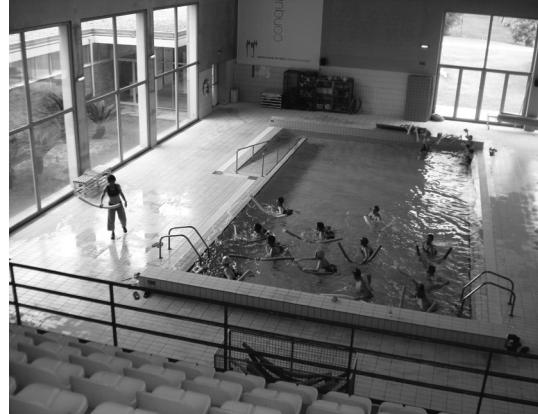
Figura 108: Acesso ao tanque não regulamentar (má configuração dos corrimãos).
