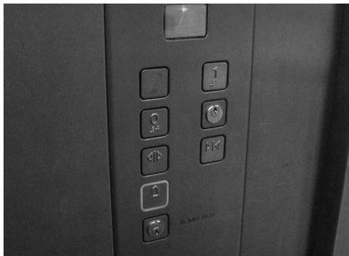
Figura 101: Dispositivos de comando acessíveis (Contém cor contrastante, Braille, informação sonora, informação visual, botão de alarme e de paragem de emergência).
