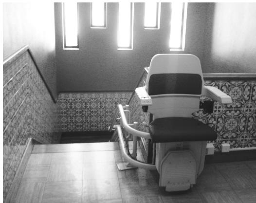
Figura 102: Cadeira elevatória rebatível não acessível (largura útil da escada:  $\leq 1,2\text{m}$ ).
